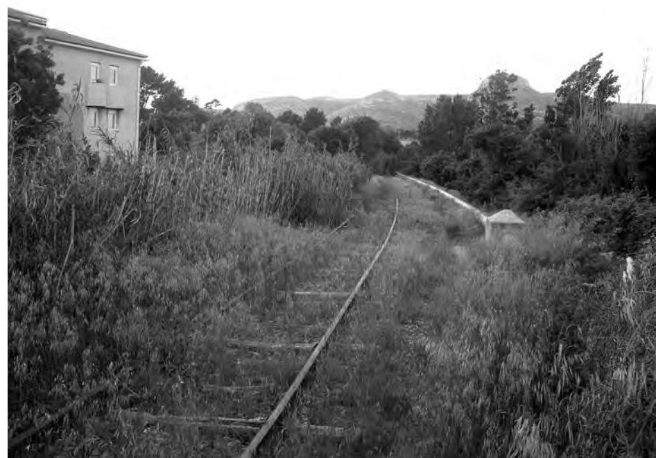
Voie de Valdonne à l'abandon dans le nord d'Aubagne
